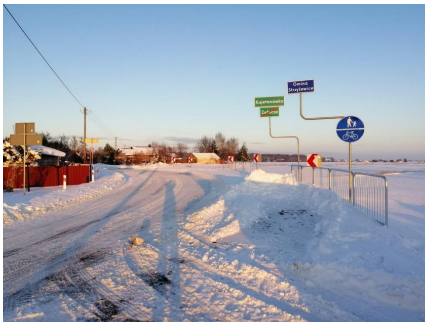
Rozbudowa drogi powiatowej nr 2290L Sobieszczany – Załucze
