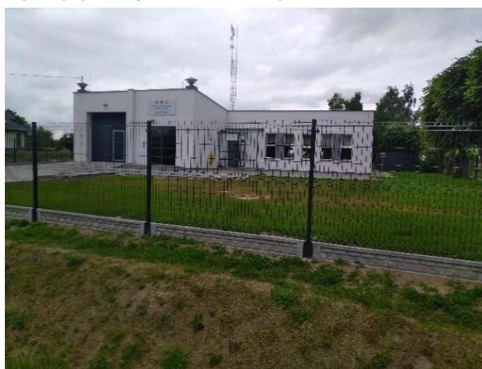
Nowe ogrodzenie wokół budynku OSP i świetlicy w Bystrzycy Starej
